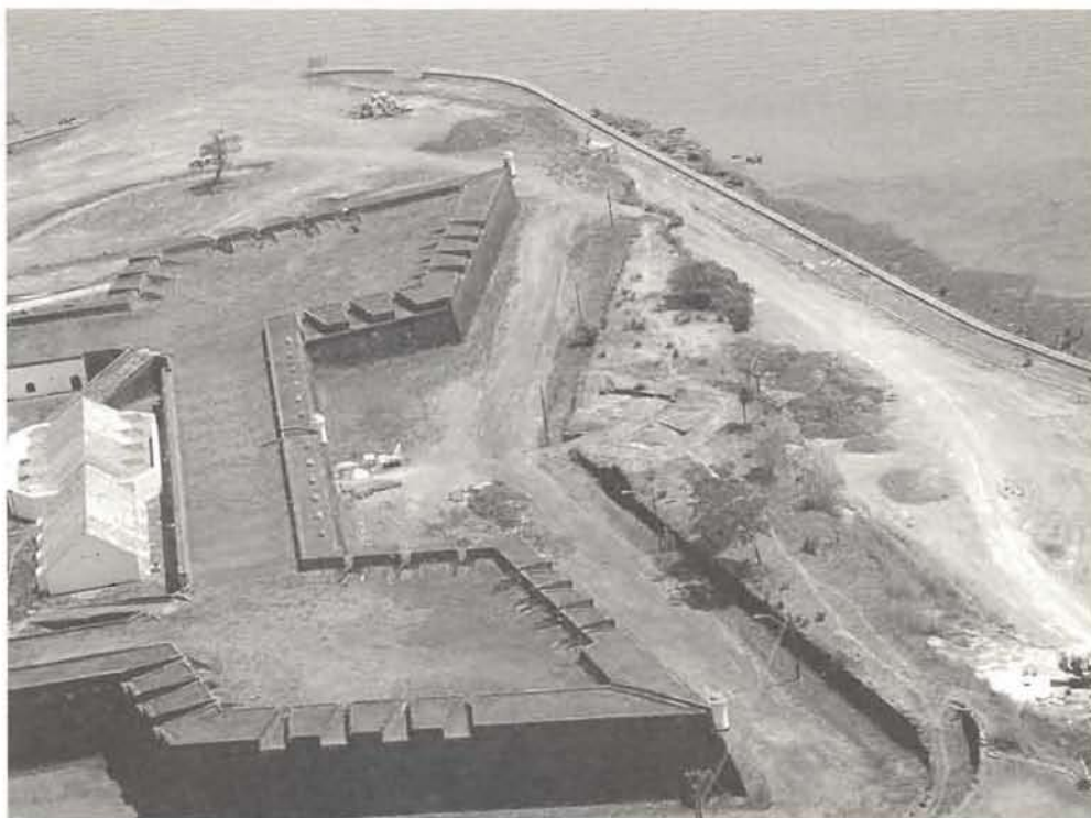
► Figura 12. Vista aérea da face entre os baluartes da Madre de Deus e de Santo Antônio, onde se vê, em frente à poterna no centro da cortina, o redente resgatado pela pesquisa arqueológica. Foto: Acervo do Laboratório de Arqueologia, UFPE.
